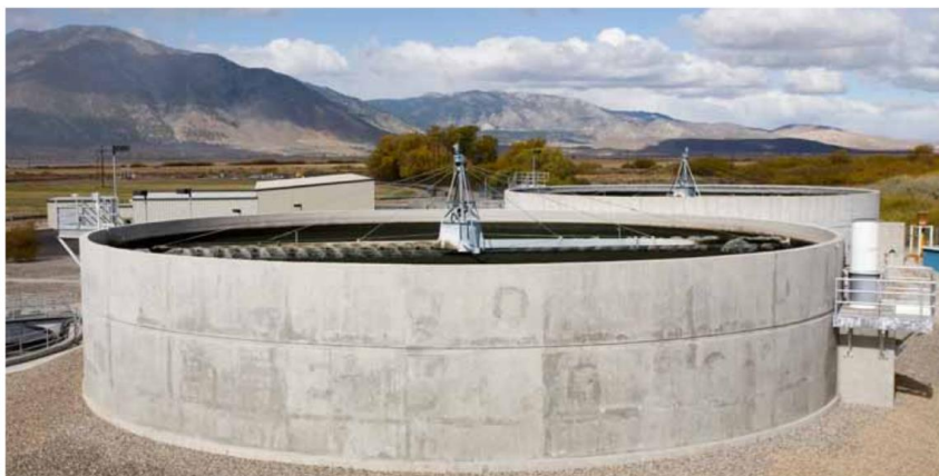
Ilustración 1 Imagen de un biofiltro de goteo. (Farmer, G. 2013)
